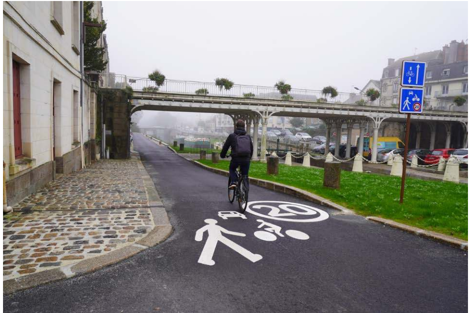
La nouvelle voie partagée sur le quai Amiral de la Grandière.
