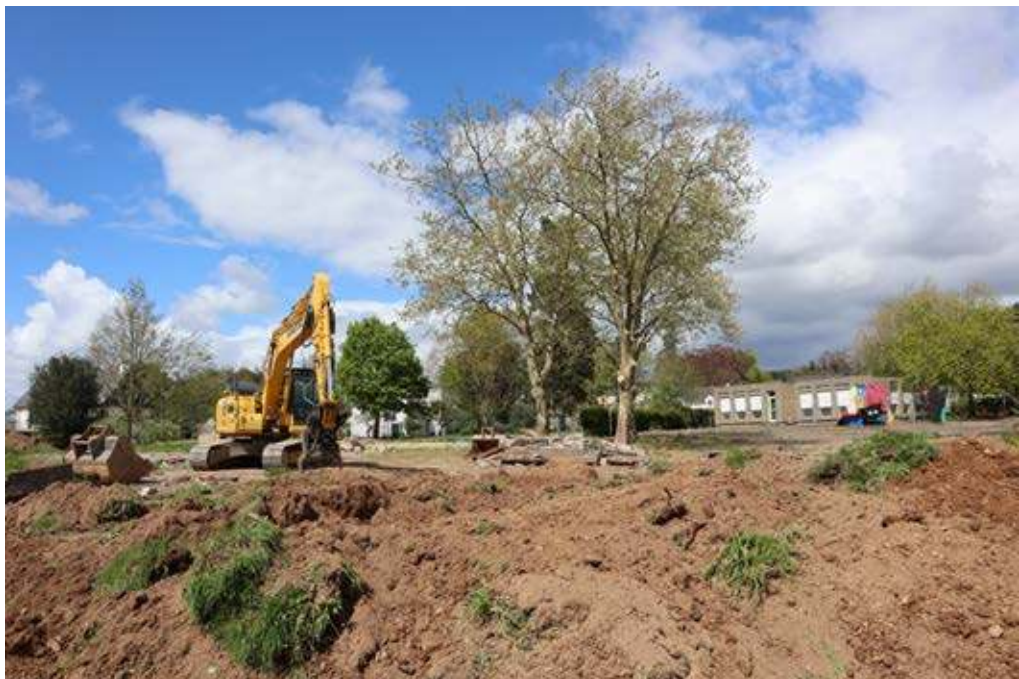
Les travaux de terrassement ont débuté mi-avril sur le site de l'école Charlie-Chaplin.
