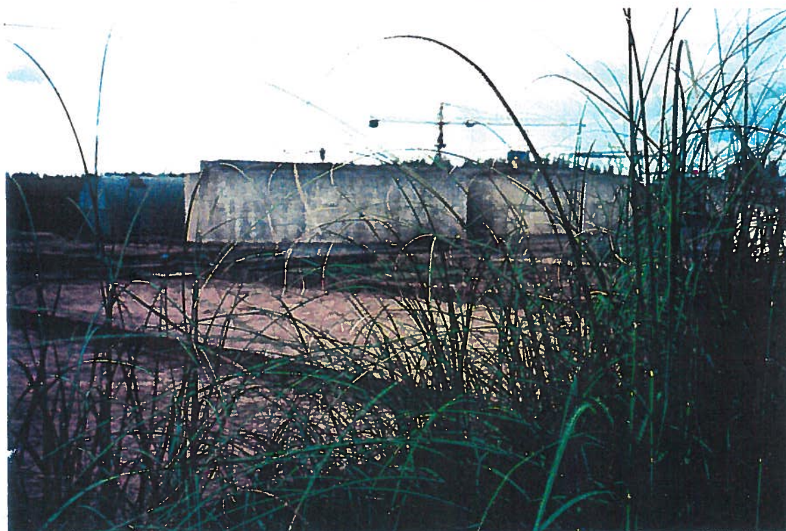
REDON : Station d'épuration sur la ZIP
